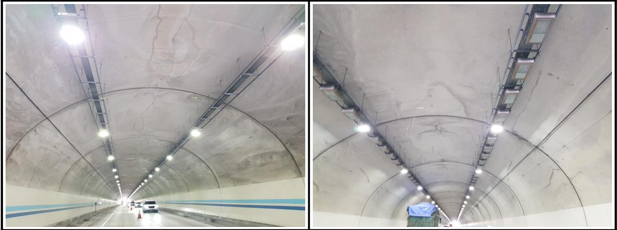
【사진 5.3.15】 라이닝 천단부 전경
