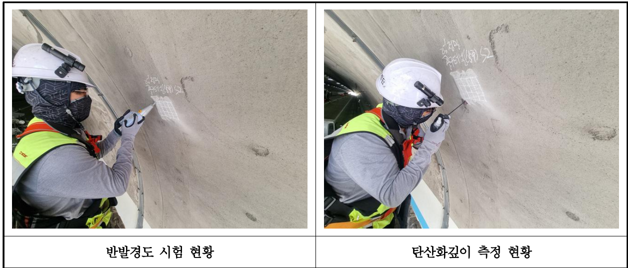
【사진 5.4.1】 콘크리트 내구성조사 현황
