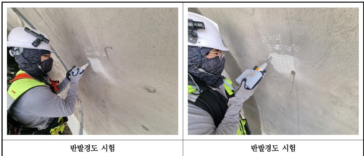
【사진 5.4.2】 반발경도시험 현장사진
