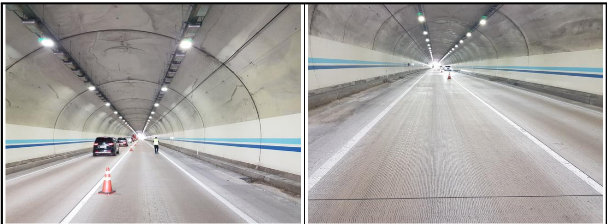
【사진 5.3.25】 포장부 전경
