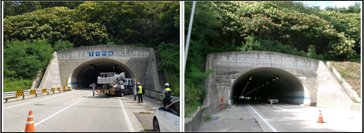
【사진 5.3.19】 갯문 전경
