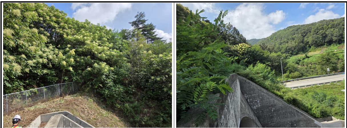
【사진 5.3.7】 사면 전경
