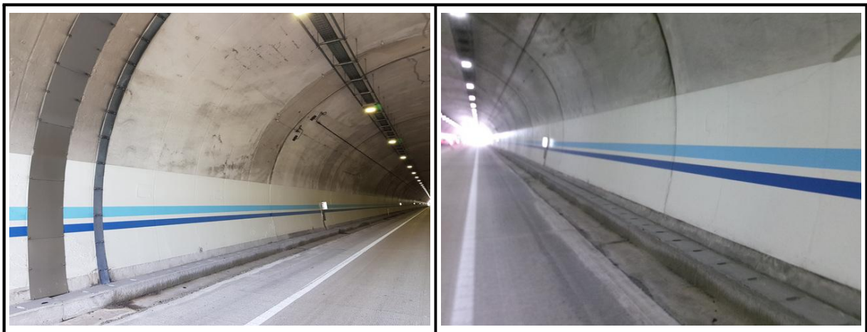
【사진 5.3.3】 라이닝 측벽부 전경
