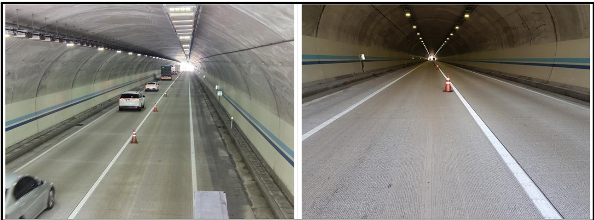
【사진 5.3.11】 포장부 전경
