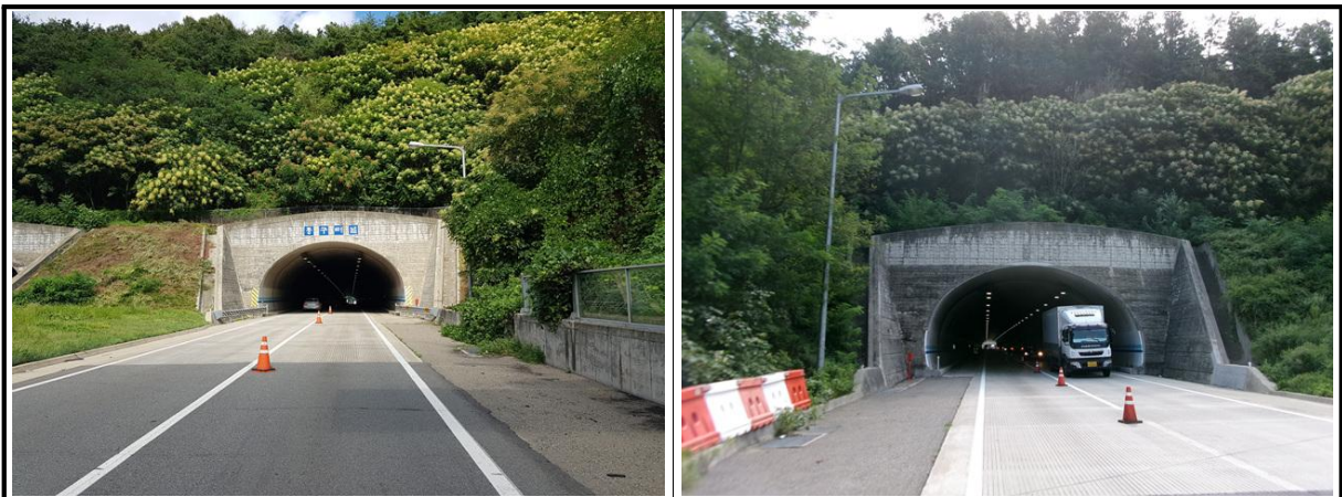
【사진 5.3.5】 갭문 전경
