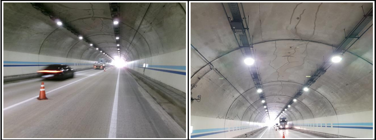
【사진 5.3.1】 라이닝 천단부 전경
