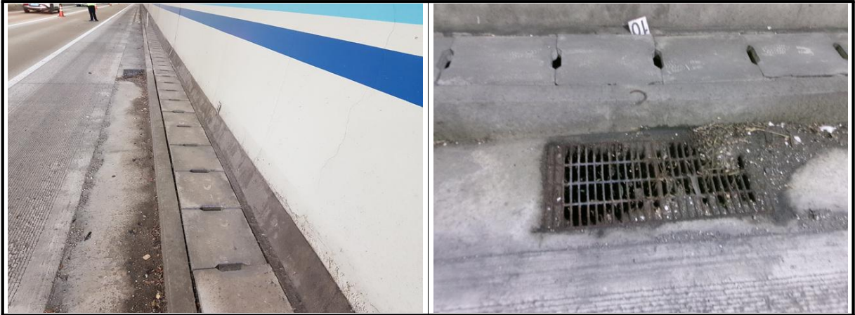
【사진 5.3.23】 공동구 및 배수시설 전경
