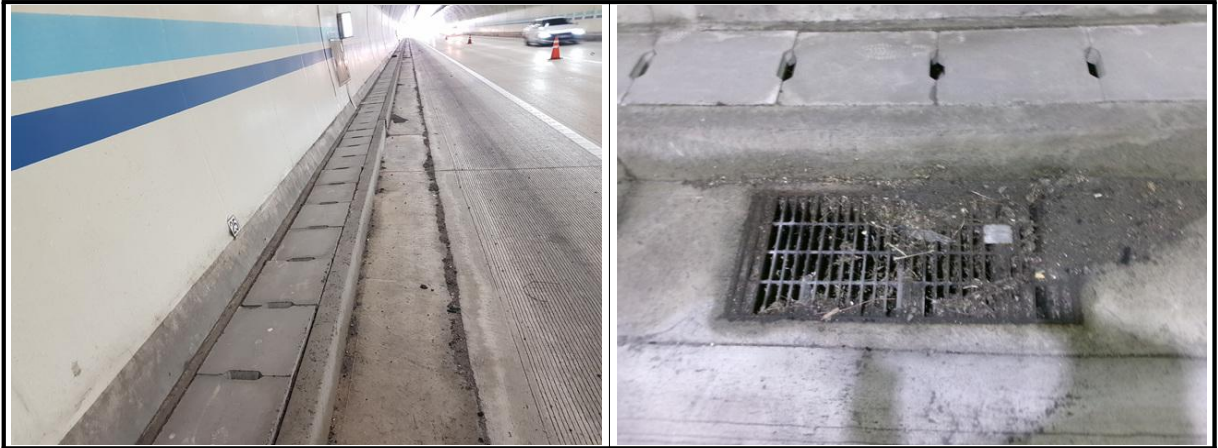
【사진 5.3.9】 공동구 및 배수시설 전경
