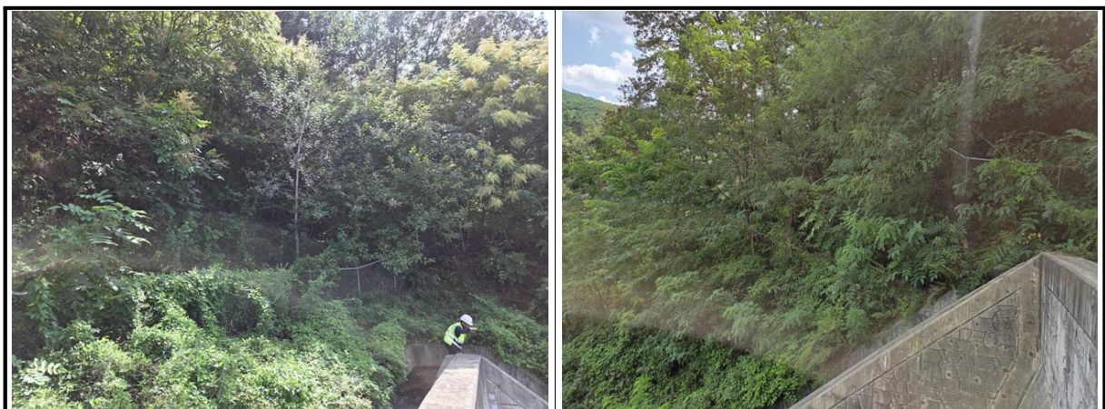
【사진 5.3.21】 사면 전경
