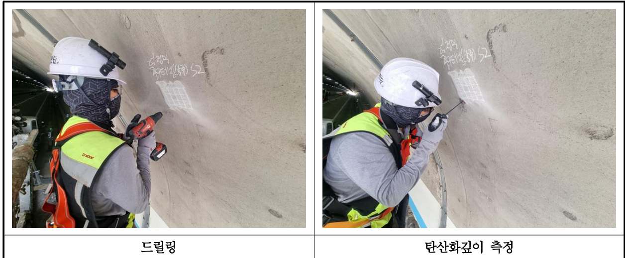
【사진 5.4.3】 탄산화 깊이 측정 현장사진
