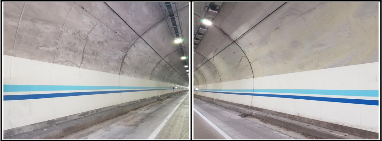
【사진 5.3.17】 라이닝 측벽부 전경
